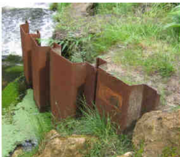
Exemple du modèle de palplanches demandé (PAL31-50)
